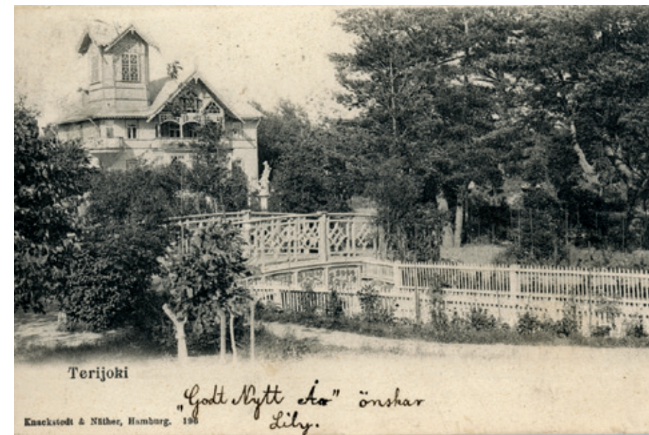
Tyypillinen esimerkki Terijoen koristeellisesta puuarkkitehtuurista oli Paul Marceroun huvila. Keisarillisen arkkitehtiliiton ranskalaisyyntyinen rahastonhoitaja hoiti huvilallaan upeaa kukkatarhaa. Vallankumouksen jälkeen huvilassa asui Marceroun tytär miehensä kanssa. Neuvostoliitossa huvilasta tuli osa lepokoti Bolševikia. Huvila ei ole säilynyt. Kuva-arkisto. Lappeenrannan museot.
