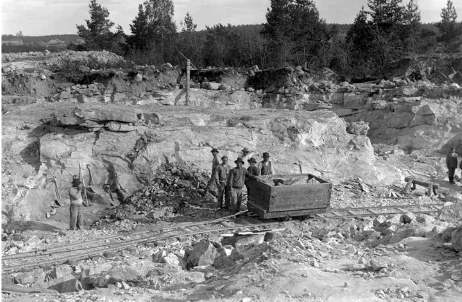
Kuparsaaren kalkkilouhoksella raidetta pitkin kulkevalla vaunulla siirrettiin kiveä. Louhoksen keskelle on jätetty louhimatta etelä-kaakkois-suuntainen kallio. - Kuva: Max Sergelius, 1904. Geologian tutkimuskeskus, GTK.
