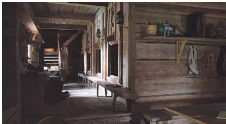
Viljamakasiinin laarit ovat irti lattiasta, pölkkyjen päällä, ja irti seinistä, ettei kairaamalla ole päästy varastamaan viljaa.
