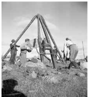
Tankkiestettä rakennetaan Enkkuussa syyskesällä-39.
