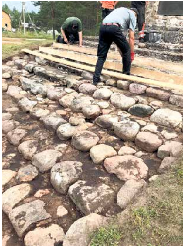
Maan kuorinnan jälkeen porraskiviä täydennettiin ennen valutöiden aloittamista.
