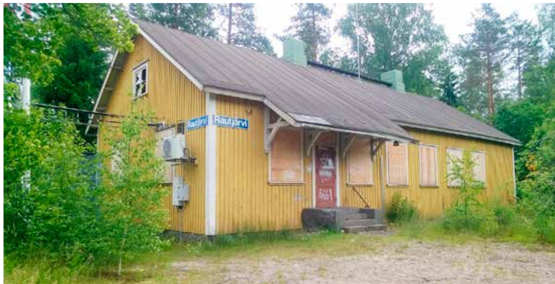
Rautjärven asemarakennus seisoo nyt tyhjiään.
