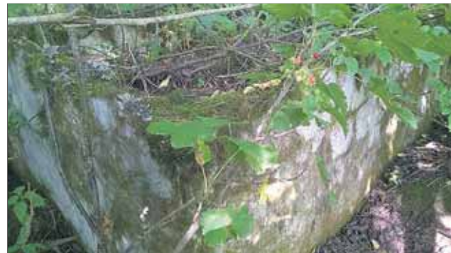
Kortemäen navetta- ja ulkorakennuksesta maan- tien toisella puolella on jäljellä enää mm. osa kivijalkaa ja koneromuja. Kuva: Maritta Kemp- pi.
