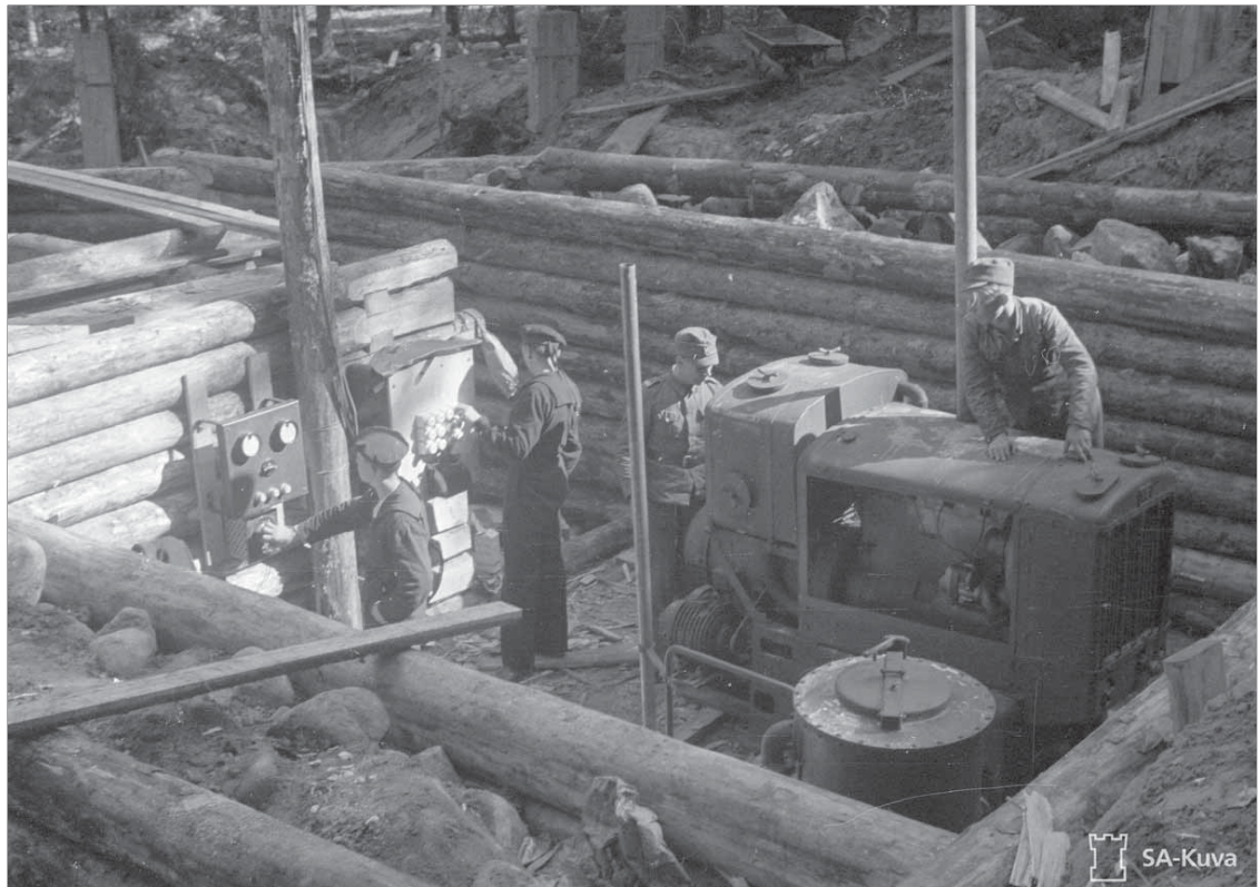
Sortanlahden suuren komentosuuren yhteyteen rakennetaan voimalaitoskorsu. Siihen on sijoitettu venäläinen puukaasutaja sekä samaa valmistetta oleva moottori ja generaattori. Sortanlahti 29.8.1942.
