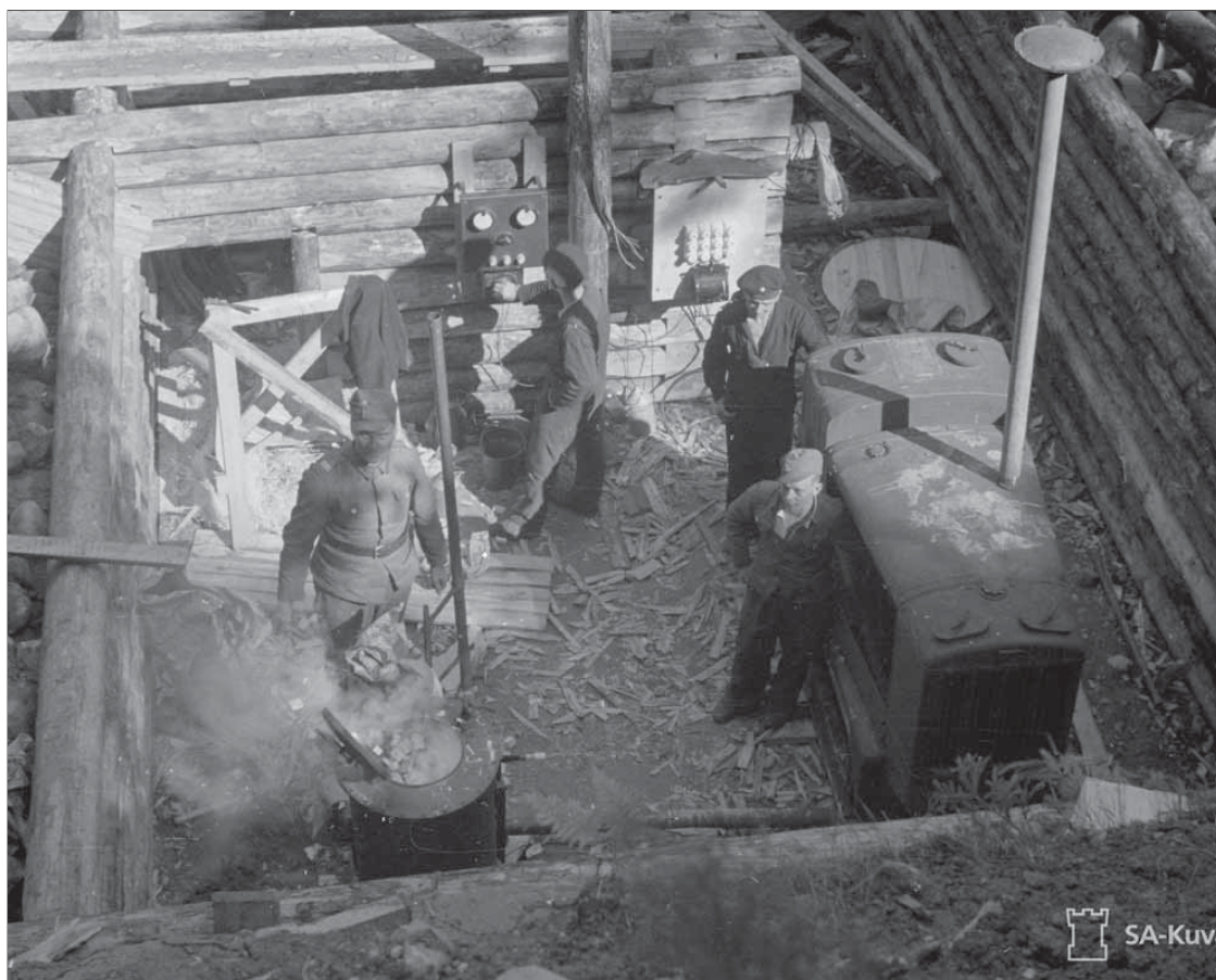
Sortanlahden suuren komentokorsun yhteyteen rakennetaan voimalaitoskorsu. Siihen on sijoitettu venäläinen puukaasutaja sekä samaa valmistetta oleva moottori ja generaattori. Sortanlahti 29.8.1942.
