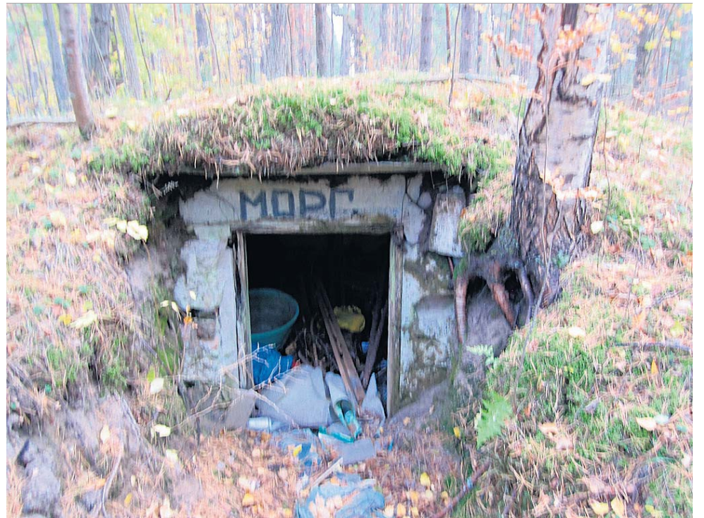
Parihuoneen oviaukko nykykunnossaan, hieman sortuneena ja roskaisena.
