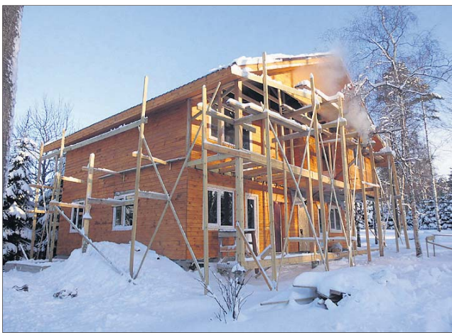
Tämä uudisrakennus on yksi kolmesta, jotka valmistuttuaan laajentavat Pyhäjärven Lomarannan majoituskapasiteettia kaksinkertaiseksi. Kuva: Seija Pärssinen.
