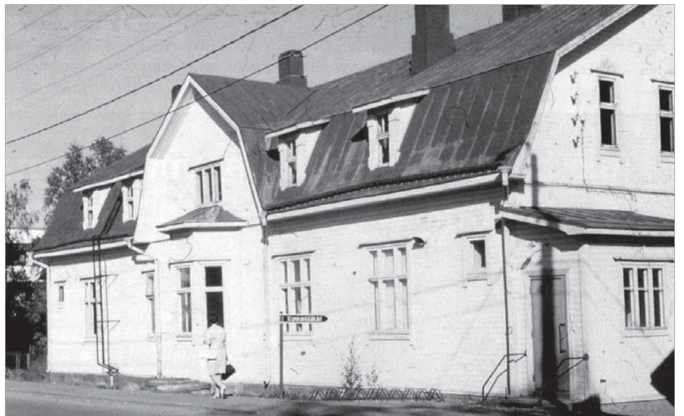
Kunnanlääkäri Arajärven asunto- ja vastaanottotilat sijaitsevat torin lähellä olleessa, nyt jo puretussa talossa. Kuva: Junno Välimaa.
