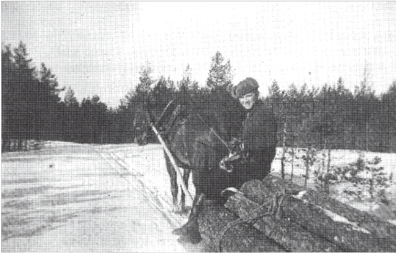
Matti Karttunen ajamassa rakennuspuita uutta kotia varten talvella 1942.
