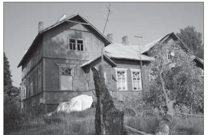
Konnitsan koulun edessä ollut koivuvanhus oli kaatunut myrskyssä kohti koulua, muttei ollut vahingoittanut rakennusta.
