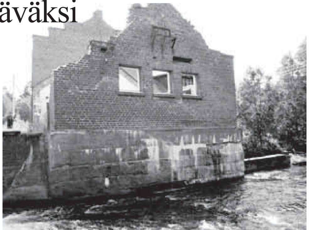
Myllyn seinää kuvattuna padon alapuolelta 14.8.2010.
