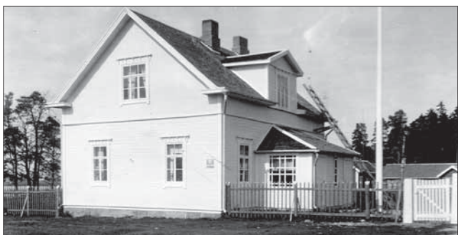
Matin rakentama kauppias Pusan talo Pyhäjärven Sortanlahdessa.
