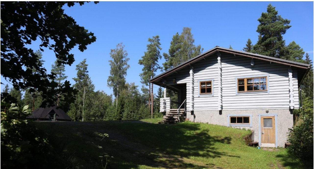
Levon metsästysmaja laiturin suunnasta kuvattuna alkuvuokosta, jolloin sää oli vielä parhaimmillaan. Kellarikerroksessa olevan saunan ovelta johtaa polku suoraan rantaan ja laiturille.
