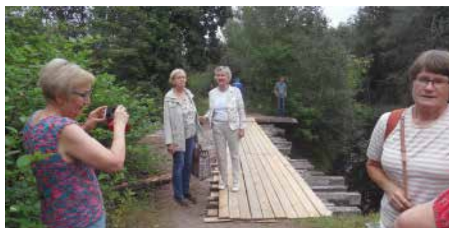
Entinen valtatie Rakkola–Sipilä–Viipuri, Sipilän kohdalta silta on saanut uutta kantta
