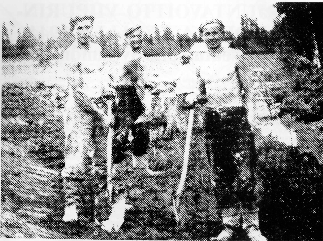
Kuvassa vasemmalta Olavi Hauhia, Niilo Hämäläinen ja Pentti Koskelainan Kapaojan kaivuutyössä.
