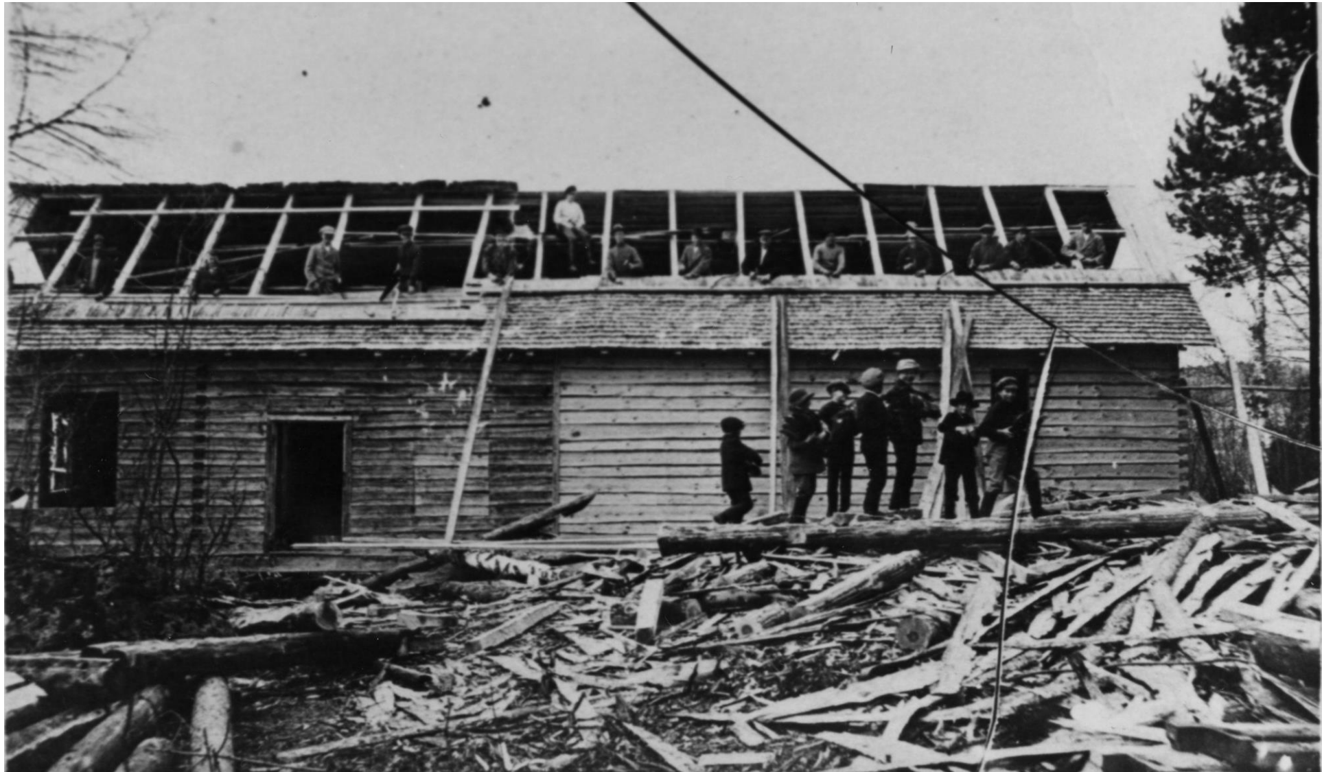
Laukkalan seuratalon rakennustyömaa n. 1923. Kuvassa miesjoukko kattamassa seuratalon rakennusta päreillä
