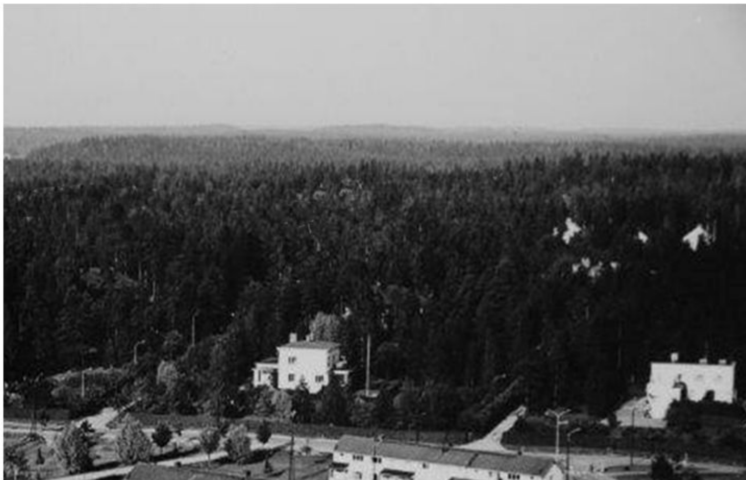
Teppanalassa Oy Vuoksenniska Ab ylemmän johdon funtionalistiset asuintalot Ensontien itäpuolella 1930-luvun puolivälistä
