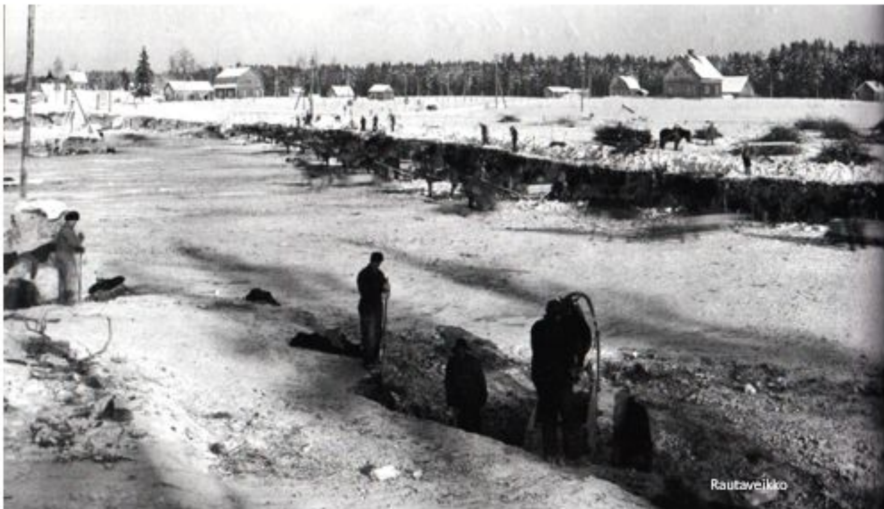
Rautatehtaan perustusten maansiirtotöitä Kyörolän kylässä v.1936
