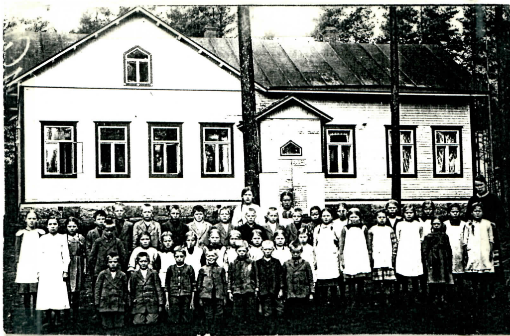
Lukuvuosi 1919–1920. Alkuperäinen koulurakennus etelästä päin kuvattuna. Keskellä sisäänkäynti opettajan asuntoon.
