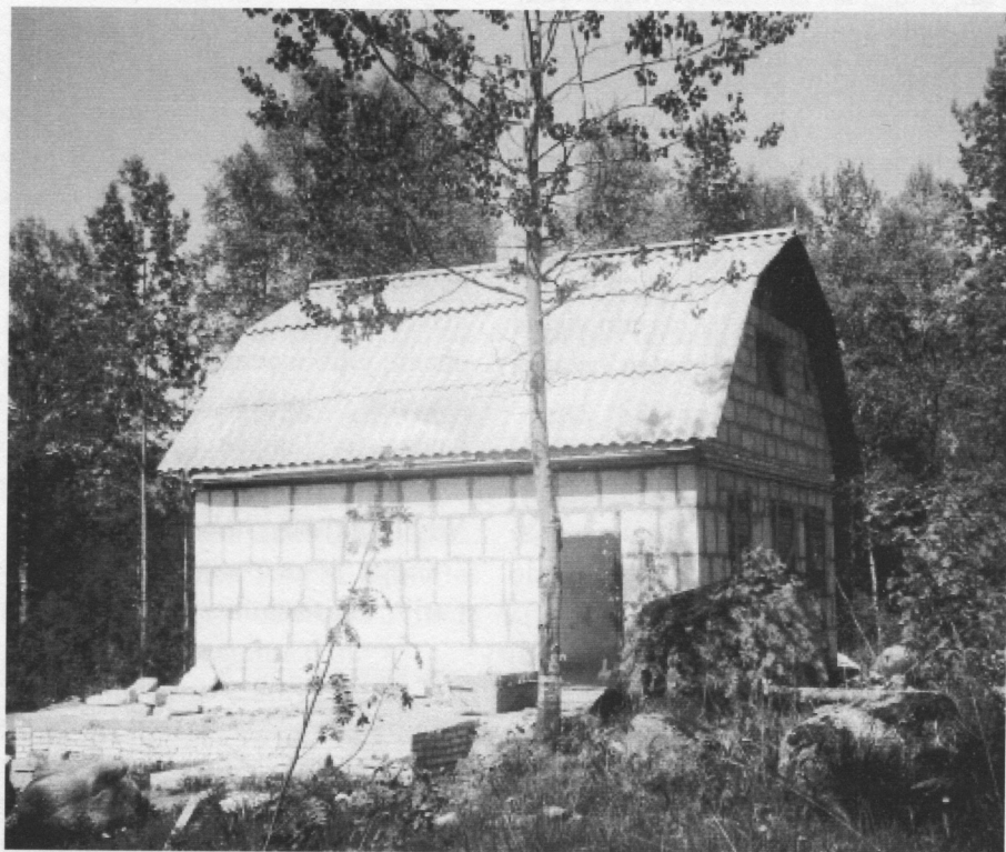
Eljas Pynnisen pihapiirissä on nykyisin venäläisen professorin kesähuvila. Kuvassa talo vielä rakennusvaiheessa.
