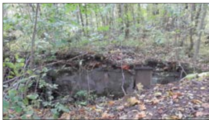
Kuva 1: Romahtanut osa kirkon sisäänkäynnin kulmassa vanhan pappilan sokkelin alla
